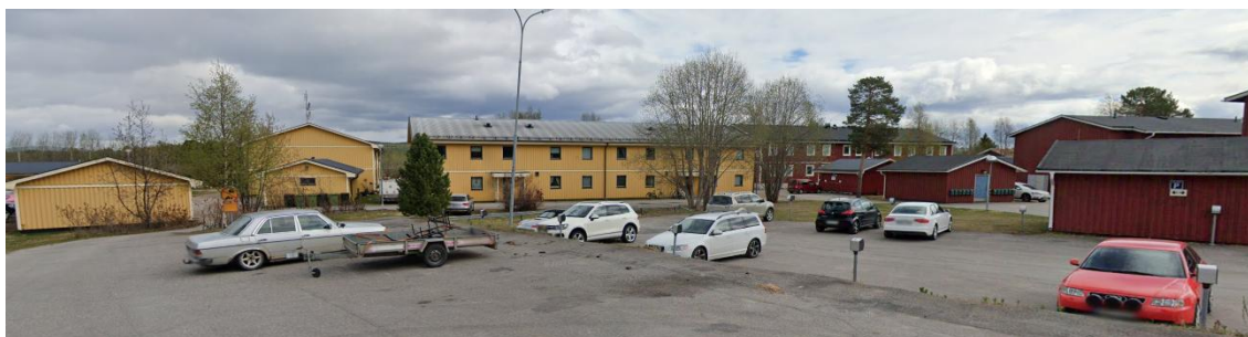
Figur 13 Foto över bostadsområde på fastighet Öberget 1:5 (Norconsult)
